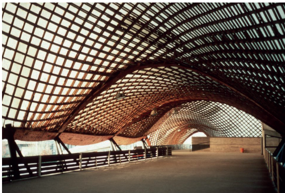
Multihalle Mannheim (Quelle: ILEK Institut für Leichtbau Entwerfen und Konstruieren, Universität Stuttgart)
