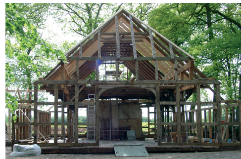
Fachwerkhaus im Wiederaufbau (Quelle: M. Schildmann)
