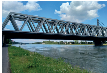
Ein Beispiel für einen Fachwerkträger: Die Eisenbahnbrücke Maxau (Quelle: F. Sandleben)
