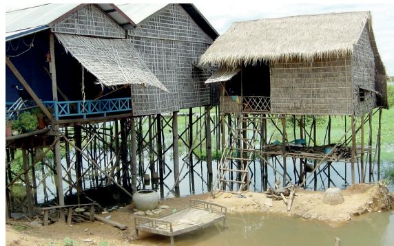
Pfahlbauten in Siem Reap, Kambodscha (Quelle: southtopia, online: https://www.flickr.com/photos/62473302@N04/7370083652 [letzter Abruf am 15. September 2021], CC BY-SA 2.0)
