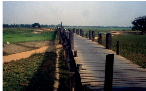
Massive Balkenbrücke aus Holzbohlen (Quelle: S. Tepel)
