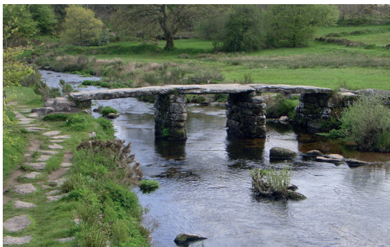
Massive Balkenbrücke aus Steinplatten (Quelle: K. Schildmann)
