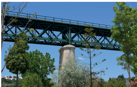
Eine Variante des Leichtbaus: Eine Balkenbrücke mit Fachwerk aus Stahl (Quelle: F. Sandleben)
